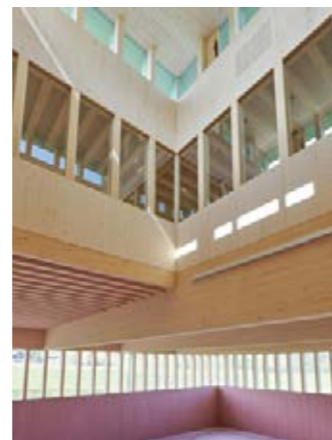
• Absturzsichere Festverglasungen mit EI60 Brandschutz in Fichte.
