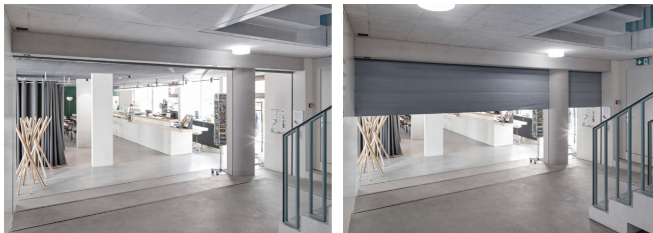
Jugendherberge Marzili in Bern: Abtrennung vertikaler Fluchtweg vom Empfangsbereich.
